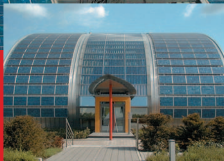
1999 Gelsenkirchen netzgekoppelte Solarstromanlage Solarmodule: 624 Stück Leistung: 68.016 KWp Größe: ca. 69 m 2
