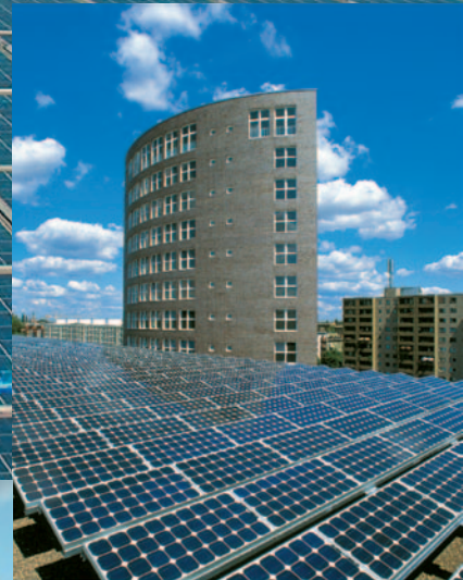
Mai 1997 Berliner Bank netzgekoppelte Solarstromanlage Solarmodule: 1056 Stück Leistung: 101.16 KWp Größe: ca. 300 m 2
