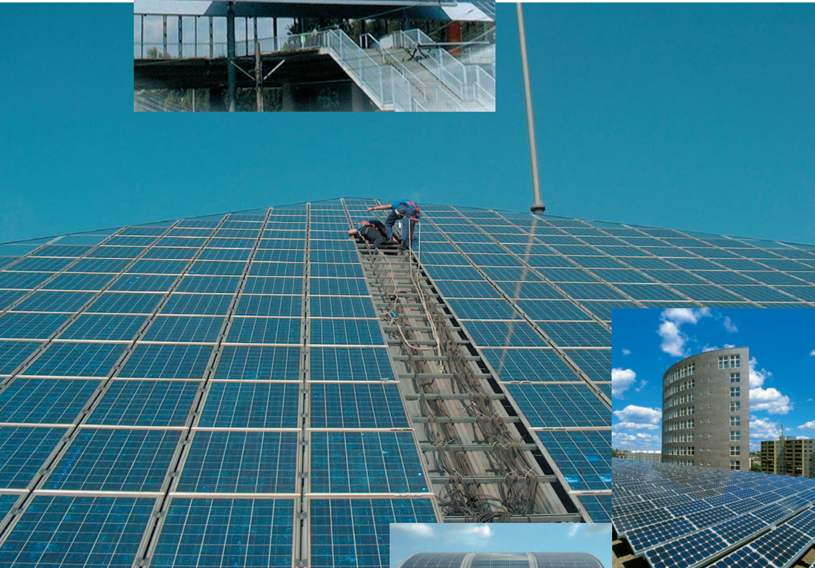
1999 Gelsenkirchen netzgekoppelte Solarstromanlage Solarmodule: 624 Stück Leistung: 68.016 KWp Größe: ca. 69 m 2
