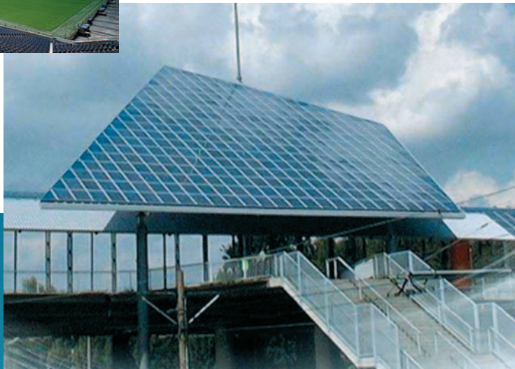
Juni 2001 Projekt "Veltins-Arena" netzgekoppelte Solarstromanlage Solarmodule: 835 Stück Leistung: 87 kWp Größe: ca. 87 m 2
