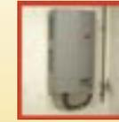
2. Der erzeugte Solargleichstrom gelangt über eine Leitung zum Wechselrichter und wird dort in Wechselstrom umgewandelt, die Stromart des öffentlichen Netzes.
