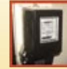
3. Über einen separaten Zähler wird die produzierte Strommenge gemessen und der Strom wird in das öffentliche Netz eingespeist. Jede Kilowattstunde wird Ihnen nach dem EEG vergütet.
