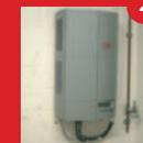
2. Der erzeugte Solargleichstrom gelangt über eine Leitung zum Wechselrichter und wird dort in Wechselstrom umgewandelt, die Stromart des öffentlichen Netzes.
